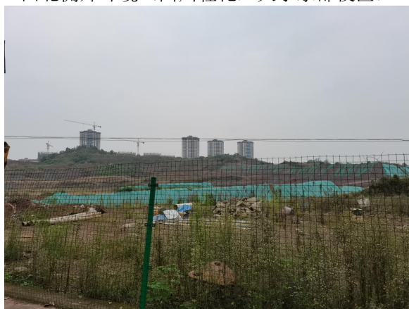
东南侧外环境（在建工地）
