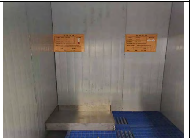
危废暂存间内部
