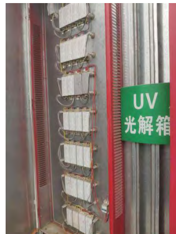
1#生产厂房底漆房废气处理设施(UV光氧)(P1-3)
