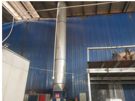
喷漆房处理设施 (排气筒) (P2-3)
