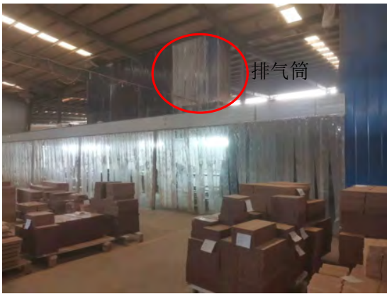
底漆打磨排气筒 (P2-8)
