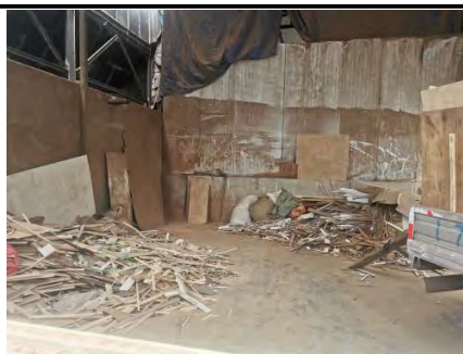
一般固废暂存间
