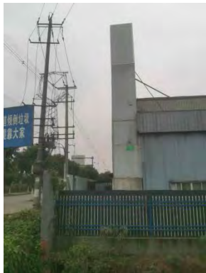
1#生产厂房干砂房排气筒 (P1-1)
