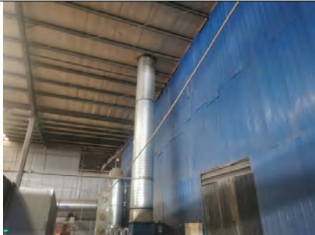
喷漆房处理设施 (排气筒) (P2-4)
