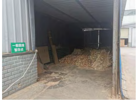
一般固废暂存间
