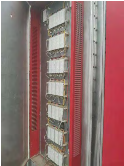
1#生产厂房底漆房废气处理设施 (UV 光氧) (P1-4)
