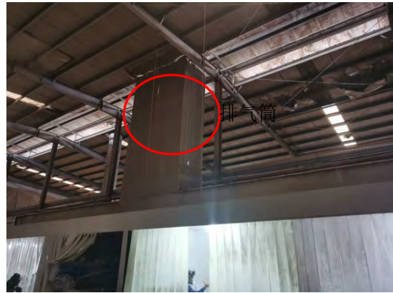
底漆打磨排气筒 (P2-9)
