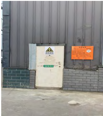
危废暂存间（外）
