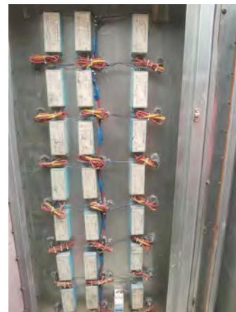
1#生产厂房面漆房废气处理设施 (等离子) (P1-2)
