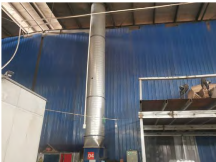
喷漆房处理设施 (排气筒) (P2-3)
