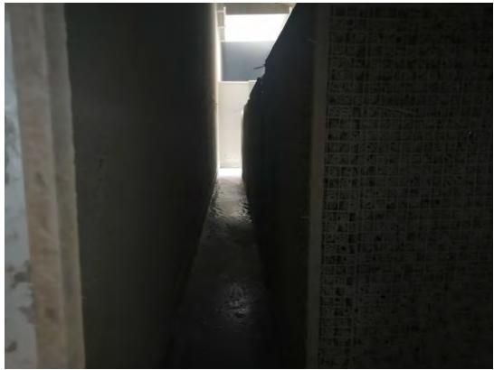
底漆打磨废气处理设施 (P2-9)
