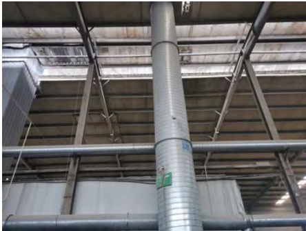
喷漆房处理设施（排气筒）（P2-5）
