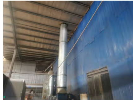
喷漆房处理设施 (排气筒) (P2-4)
