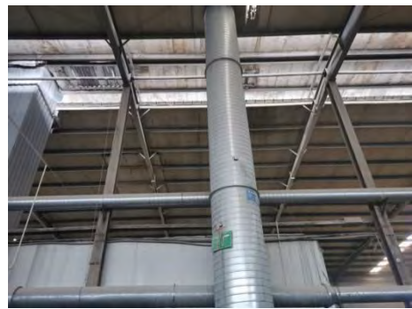
喷漆房处理设施 (排气筒) (P2-5)
