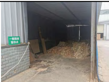
一般固废暂存间
