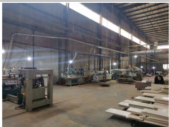
木工区及收尘管道
