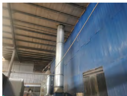
喷漆房处理设施（排气筒）（P2-6）
