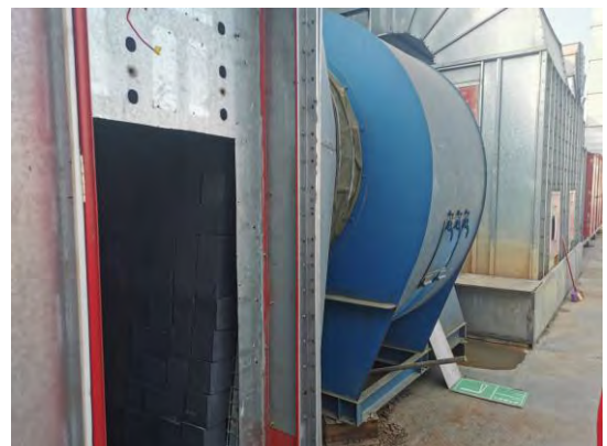
1#生产厂房底漆房废气处理设施（活性炭）（P1-3）
