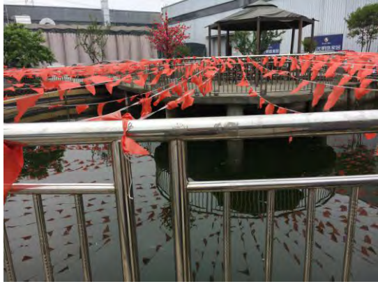
应急水池兼事故池
