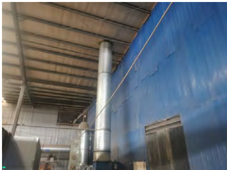
喷漆房处理设施（排气筒）（P2-6）
