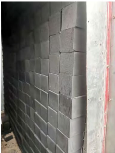
1#生产厂房底漆房废气处理设施 (活性炭) (P1-4)
