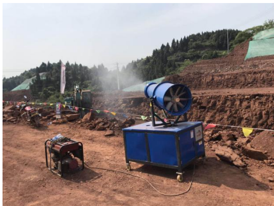
降尘措施（喷雾除尘）
