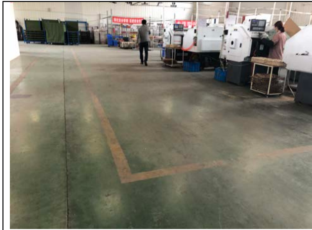
生产车间地面防渗
